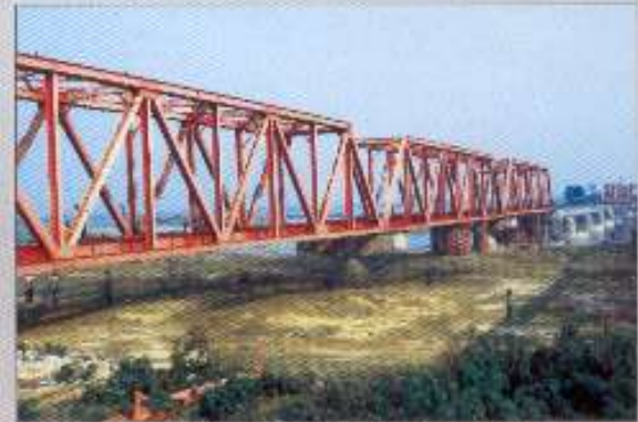
बारसोई-कटिहार गेज परिवर्तन परियोजना के अंतर्गत कंकड़ नदी के उपर निर्माणाधीन पुल सं.173
